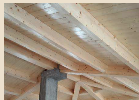
Copertura fabbricato in legno
