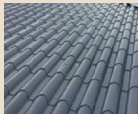
Copertura fabbricato in lattoneria
